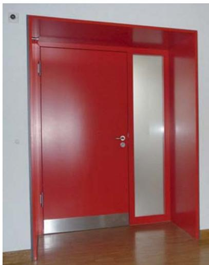
BrS-Türe EI 30 mit Dämmung
