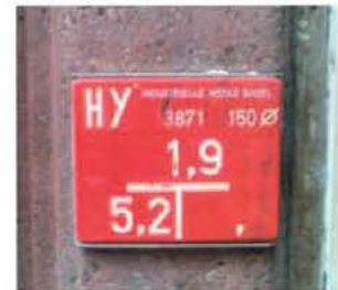
Hinweisschild Unterflurhydrant (gibt Position des Hydranten an)
