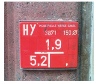
Hinweisschild Unterflurhydrant (gibt Position des Hydranten an)
