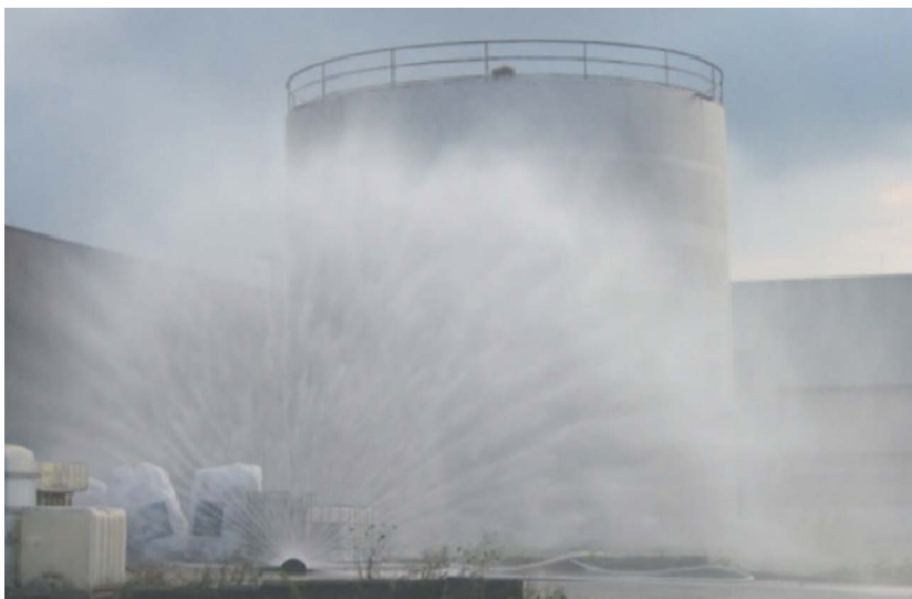
Niederschlagen von Gasen und Dämpfen mit einem Hydroschild
