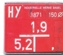
Hinweisschild Unterflurhydrant (gibt Position des Hydranten an)
