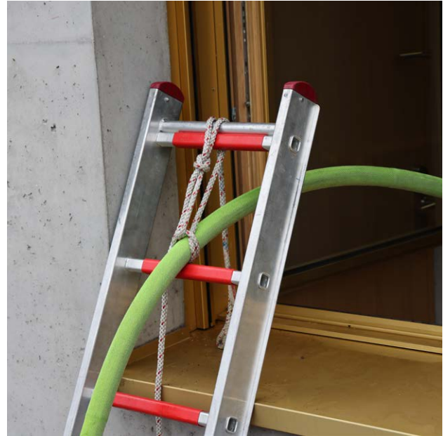
Leitung zwischen den Sprossen durchziehen und sichern
